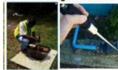
0-5000Hz の漏水探知器
