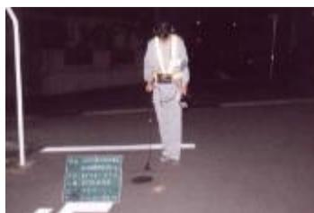
埋設管から発生する漏水音を地表面で捉える。
