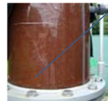
地下水中のバクテリアがろ材上に定着繁殖した状態
