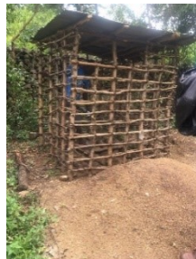
写真2. 住民自信が建設するトイレ
