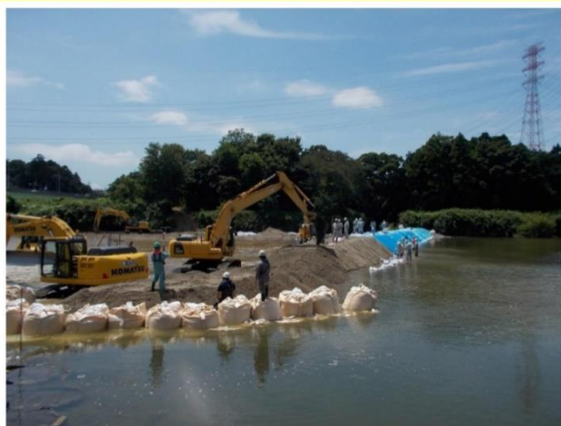
久慈川の土堰堤築堤作業
