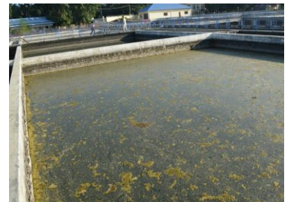
マンダレーNo.8 浄水場 沈殿前池で藻類が見える
