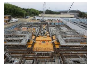
H25.10 工事中的の新設沈澱池(須江山浄水場)
