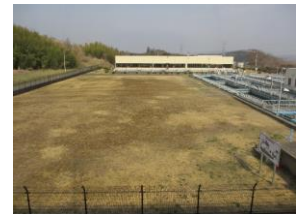
H24.4 沈澱池着工前の須江山浄水場 2 期用地
