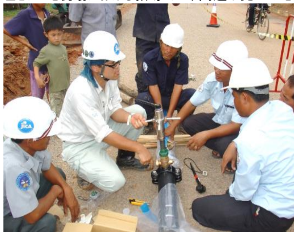
配水管布設指導(プルサット:2009 年)
