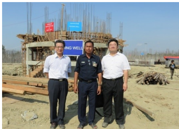
浄水場建設現場にて
