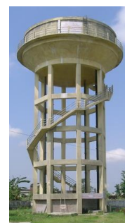
ネパールの既存施設
