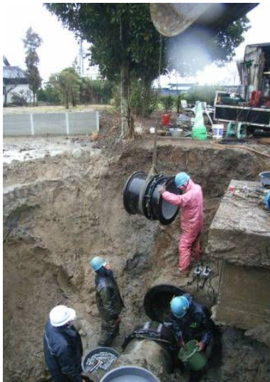
横浜隊復旧状況(日立市)
