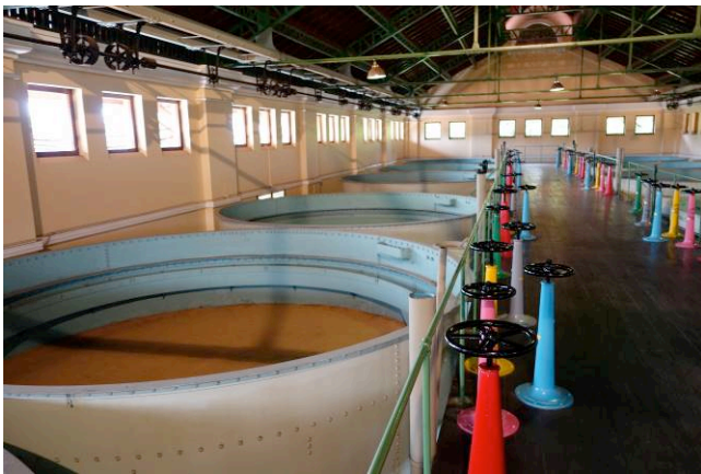
円形ろ過タンク:内部構造は急速ろ過池と同じ
