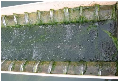
沈澱処理水集水トラフ
